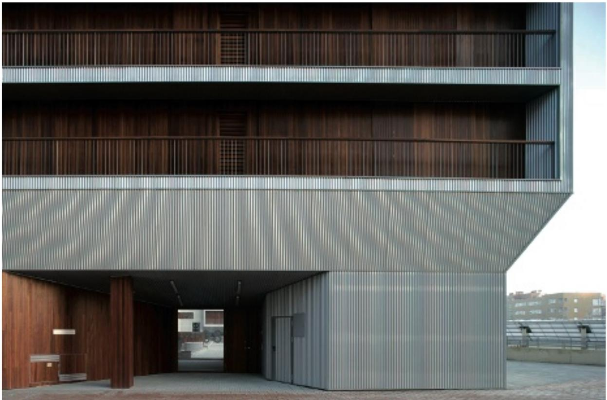
un muro de chapa continuo y enlazadas entre sí con un revestimiento de madera. Ambas se quiebran planteando diversos planos girados respecto a la alineación principal.
