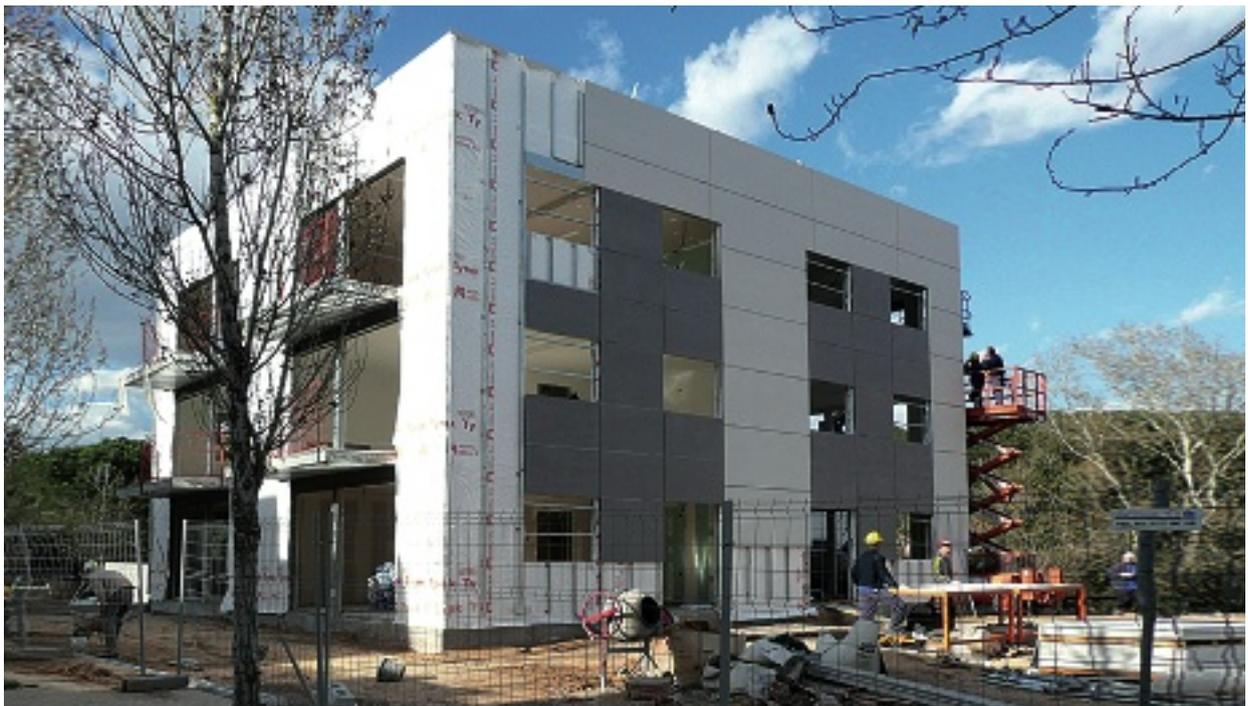
La fabricación es industrializada con material de reciclaje y de gran formato, permite la colocación en la obra en seco con un alto rendimiento, 5 m<sup>2</sup> sup./montador-día; en la cara exterior del cerramiento de fachada se colocan paneles de fibras de madera OSB de gran formato, una lamina impermeable, y placas con tecnología PVA, fabricadas con materia prima natural celulosa y cemento Pórtland reciclado, sin impacto medioambiental negativo, formando la fachada ventilada.
