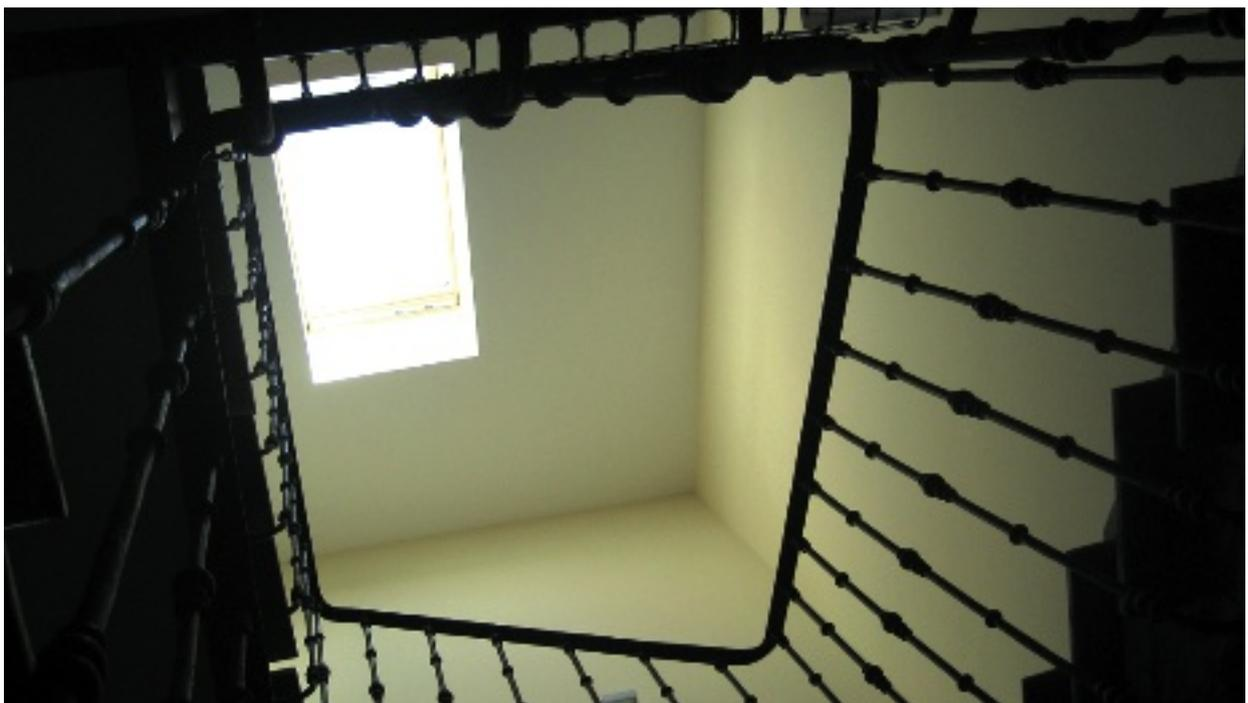
El núcleo de escaleras existente se restaura utilizando los materiales originales, madera en peldaños, cerrajería en barandillas, yesos en paredes, etc. Se proyecta un nuevo sistema de iluminación con lámparas de bajo consumo empuotrables en falsos techos.
