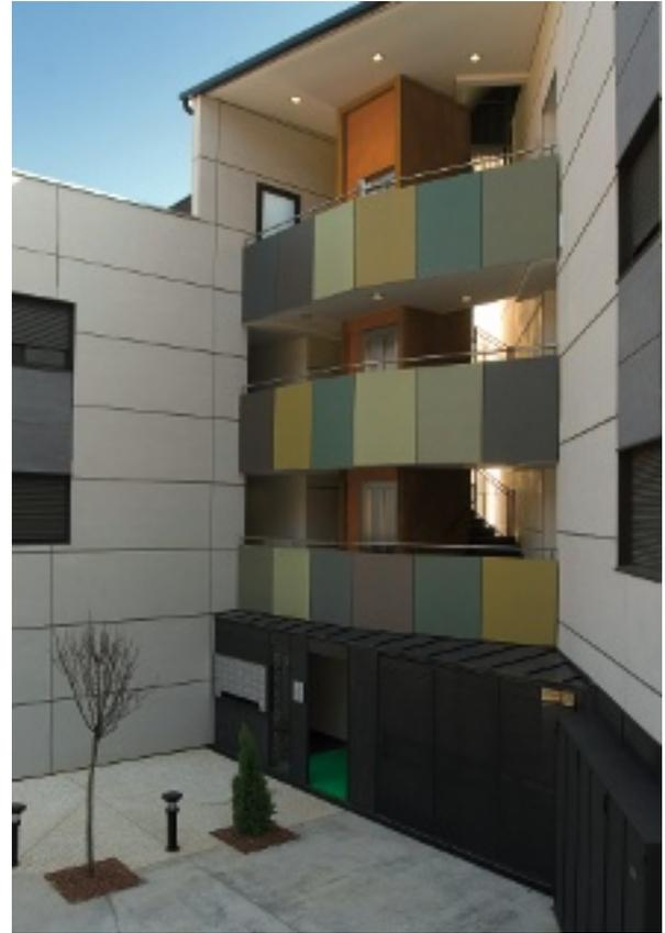
Estructura portante con muros de carga utilizando el sistema TECCON, paneles autoportantes prefabricados formados por acero estructural en perfiles ligeros y manta mineral que configuran a la vez la estructura y el cerramiento del edificio. Los forjados se construyen con chapas de acero colaborantes y losa de hormigón; es el único proceso de la obra en que interviene el agua, reduciendo así su consumo, en la estructura y cerramientos, en un 95%.
